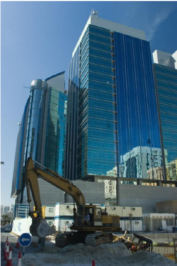
Baustelle in Abu Dhabi, Büropalast: Am Persischen Golf bieten Latein und Französisch keinen Zugang zu den Köpfen und Herzen der Menschen
